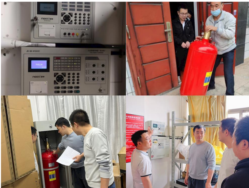
5月15日，现代信息中心党支部完成了机房消防设施升级改造工作。该机房消防设施布置年限较久，为进一步提高消防安全防护能力，现
